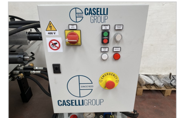
Quadro elettrico di comando
